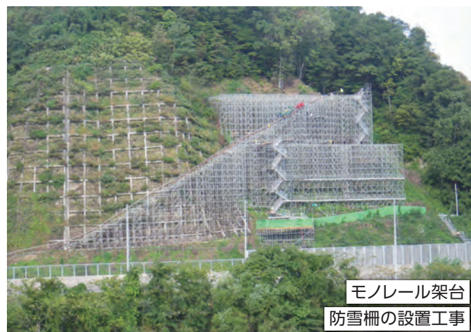
重機作業及び資機材荷取り構台
