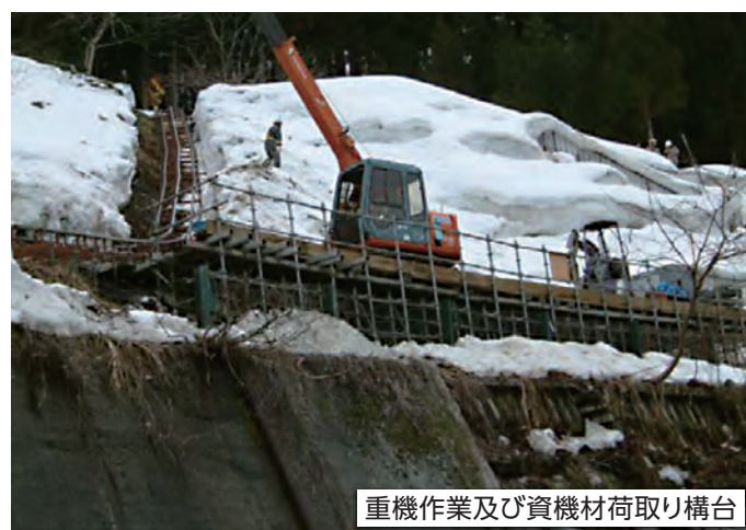
鉄塔取替作業用構台
